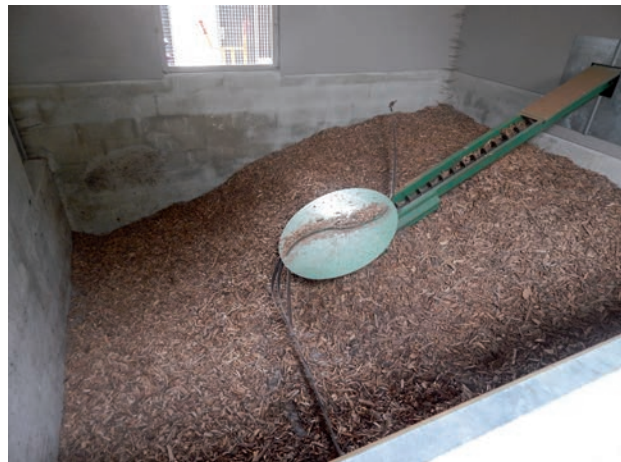
Silo de 30 m 3 avec extracteur rotatif, Milly-la-Forêt
