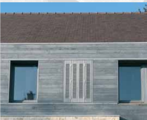
Couplée au mur en terre, une circulation d'air favorisée par les volets à persiennes assure un confort d'été accru et surtout, sans climatisation !
