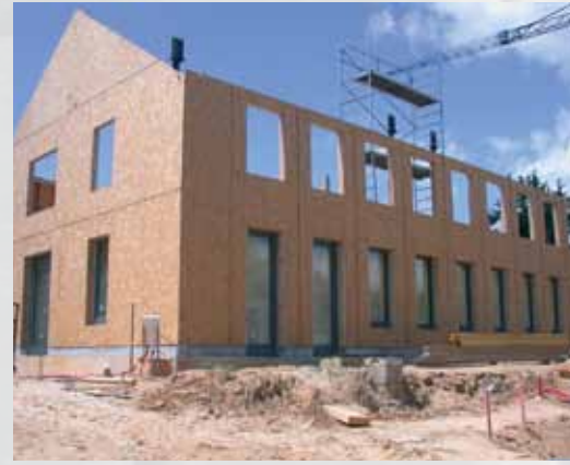
Le bois de forêts françaises (Vosges, Orléans, Alpes et Landes) pour l'ossature du bâti (isolée avec de la laine de chanvre), les bardages, la charpente, les menuiseries, l'isolation. ©Ann Carer/PNRGF
