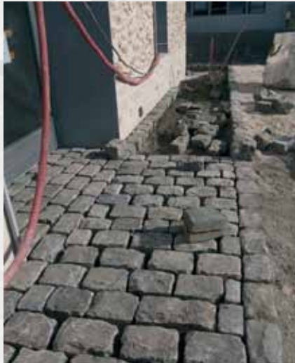
Le grès de Fontainebleau d'origine locale (carrière de Moigny-sur-École et de récupération) pour les murs et le pavage au sol. ©Ann Carer/PNRGF
