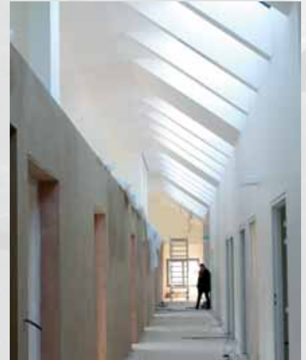
L'intérieur du bâtiment éclairé naturellement par une verrière , un plancher vitré, des impostes et des cloisons vitrées. Cela limite les besoins en éclairage artificiel (moins d'émission de gaz à effet de serre).
