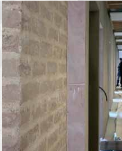
Un mur de terre à forte inertie thermique procure un confort accru en toutes saisons : il restitue la fraîcheur en été et la chaleur en hiver. Ce dispositif économise l'énergie et donc participe de la réduction des émissions de gaz à effet de serre.
