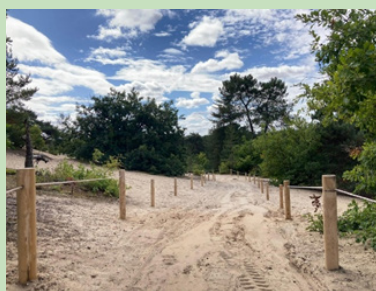
Site des pelouses sèches de Buthiers pendant la mise en place des potelets en septembre 2025
