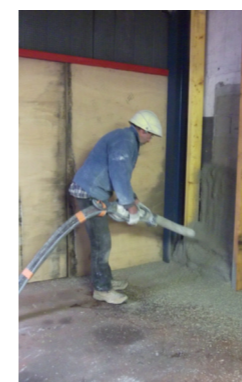
Projection de béton de chanvre
