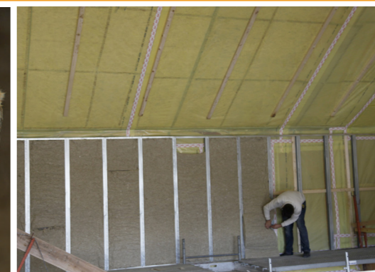
Pose de panneaux de laine de chanvre
