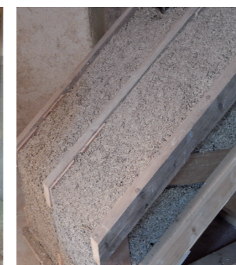
Isolation de toiture en béton de chanvre
