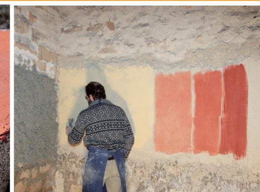
Différentes finitions en enduit chaux-chanvre
