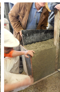
Mur en béton de chanvre banché
