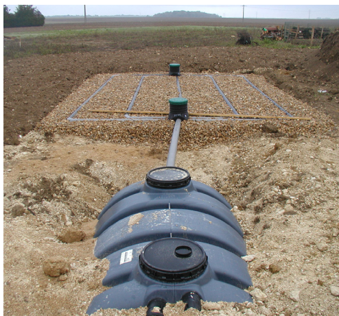
Avant les travaux
