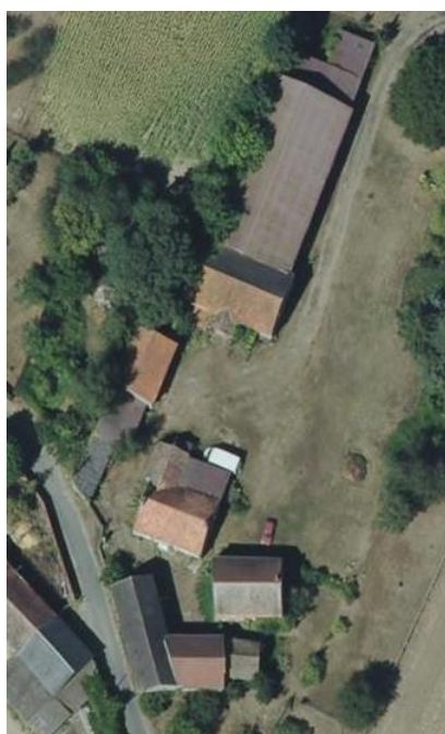
Vue aérienne de la ferme de Chanteloup (2018), géo portail
