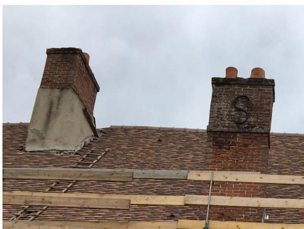
Souche de cheminée de la ferme de Gravelles
