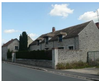
Rue brément, PNRGF
