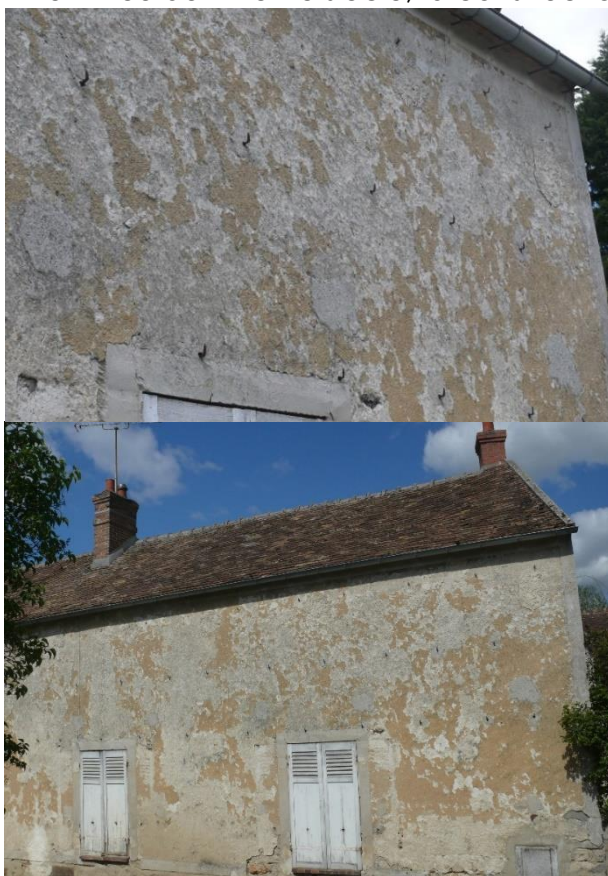
Treille sur façade, PNRGF
