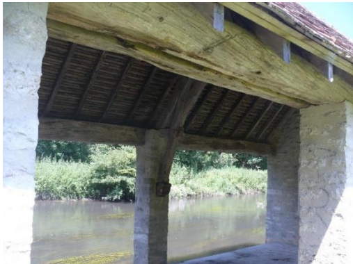
Lavoir du centre village. PNR du Gâtinais français, 2021
