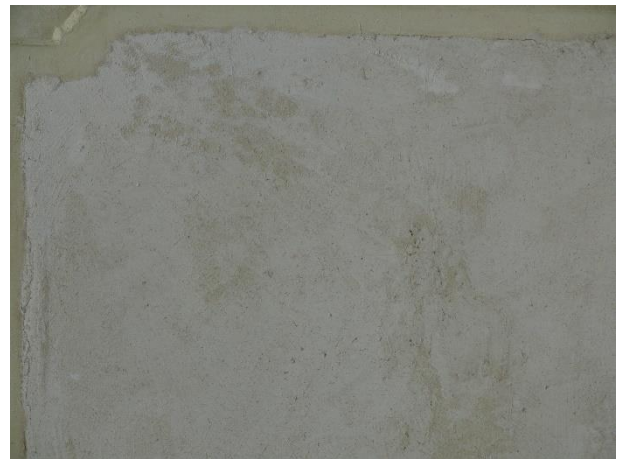
Enduit couvrant à la chaux
