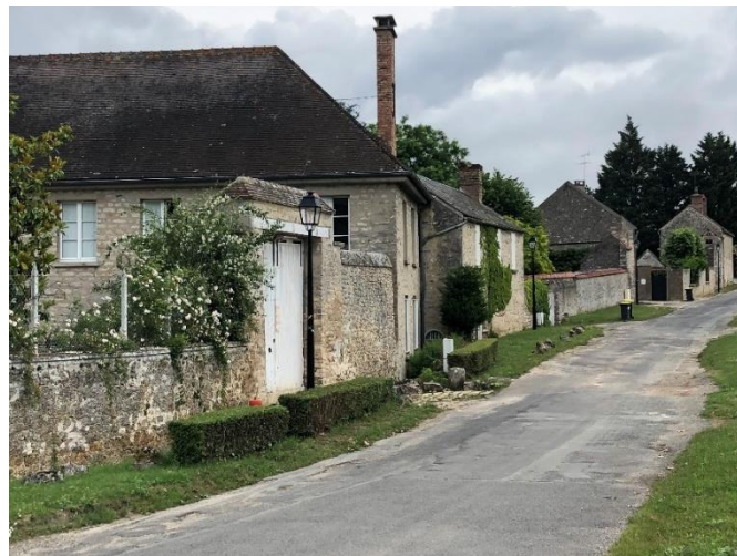
Le moulin après sa reconstruction, PNR Gâtinais français
