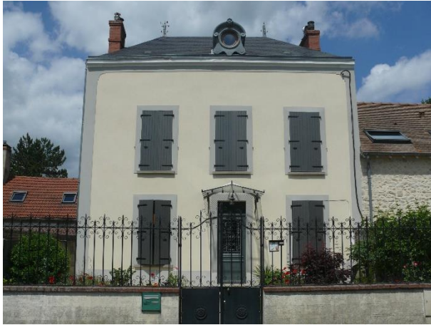
Toiture à 4 pans et épis de faîtage
