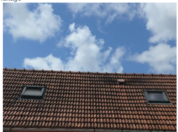
Toiture en tuiles mécaniques
