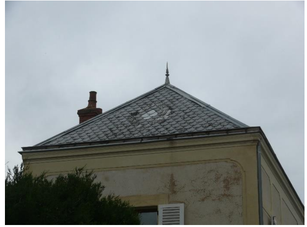
Toiture en ardoises écailles de poisson avec épis de faitage
