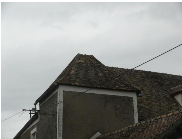
Toiture en pavillon
