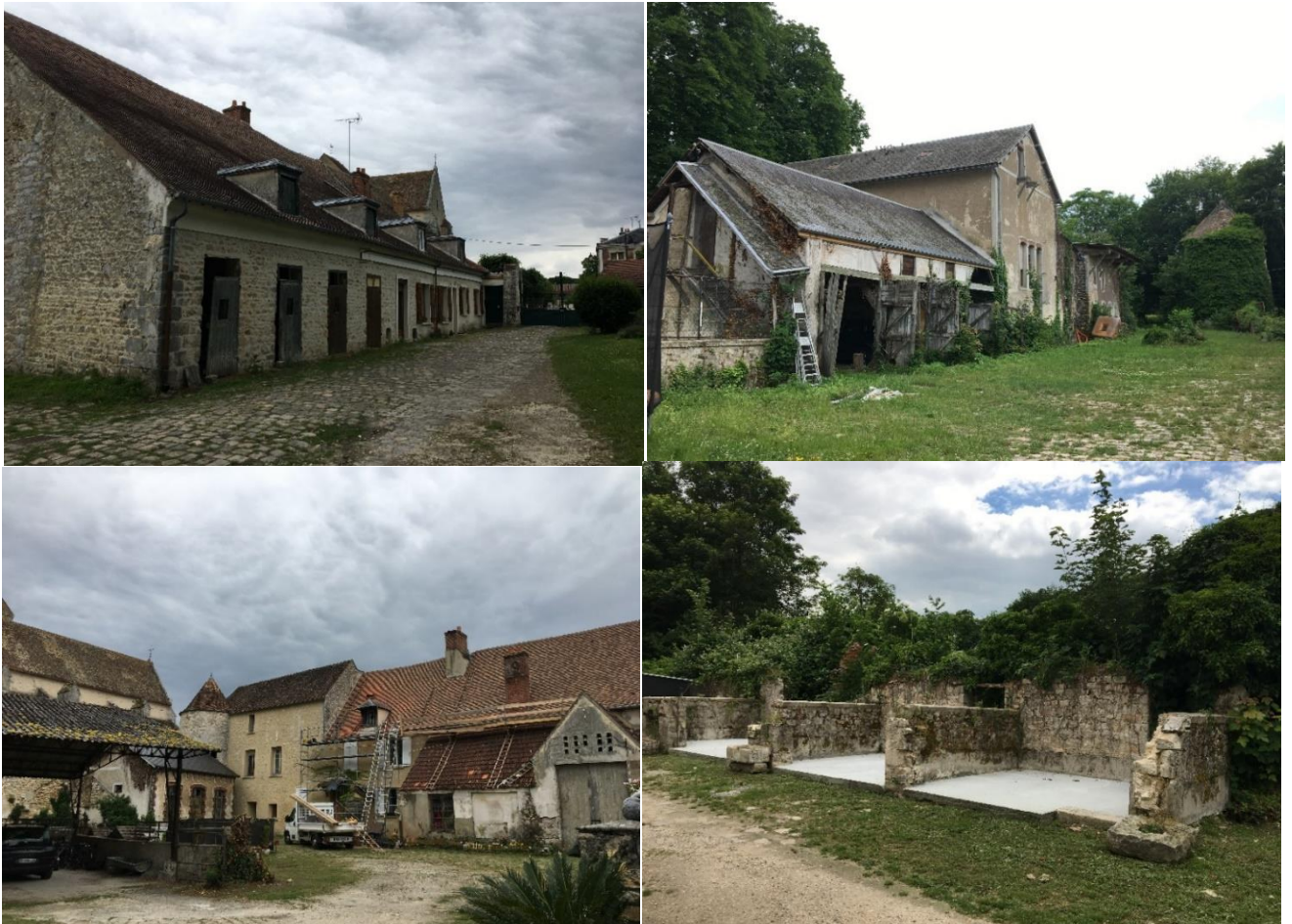
Les communs du château (granges, orangerie, laiterie et anciennes stabulations sur lesquelles une dalle de béton a été rajoutée). PNRGF
