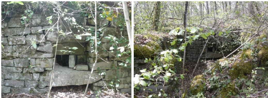
Ancien abri de carrier présent dans le Bois de la Barre, sur l'emplacement d'une ancienne carrière de grès, PNRGF
