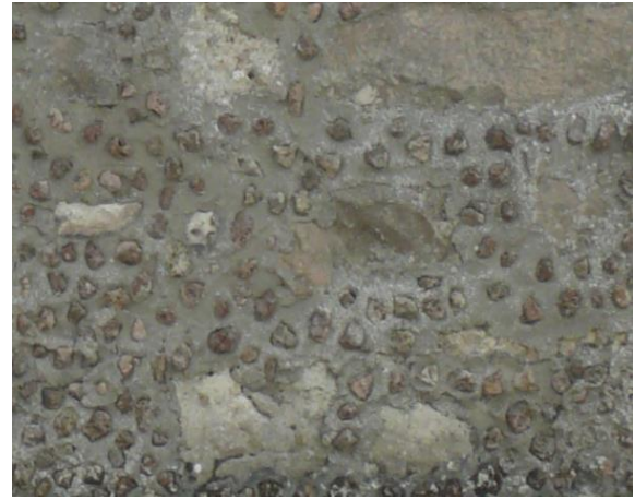
Enduits en rocaillage, PNR du Gâtinais français
