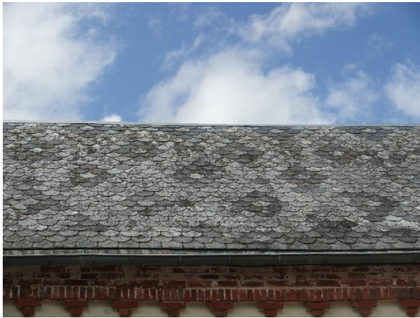
Toiture en ardoises
