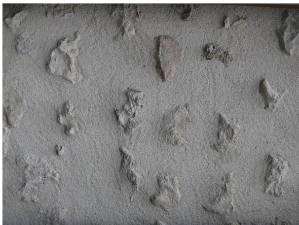
Enduit à pierre vue
