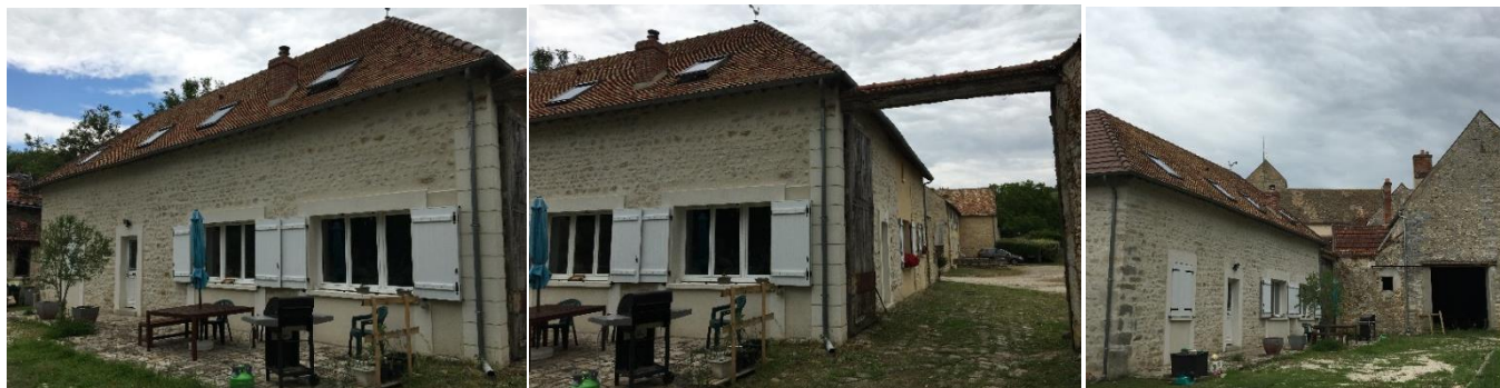
Bâtiments agricoles réhabilités en logements, PNRGF
