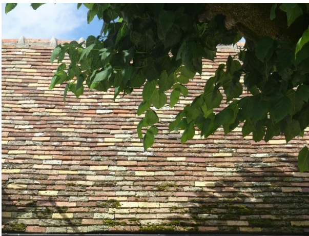
Toiture en tuiles plates
