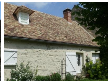
Rue brément, PNRGF
