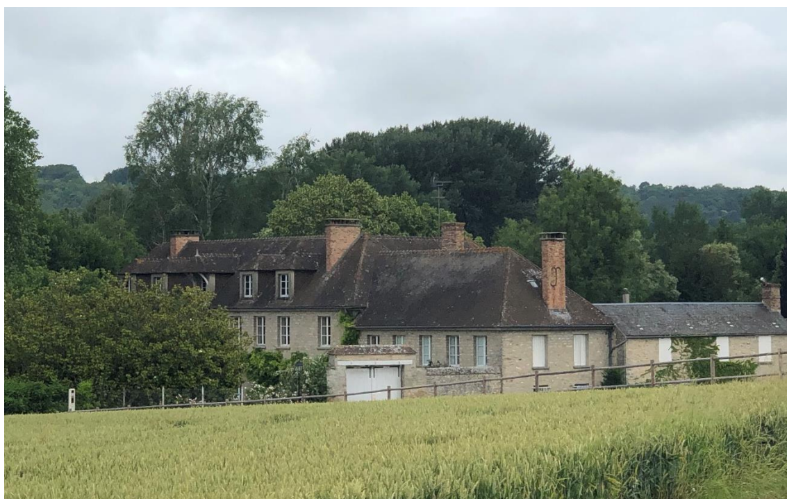
Le moulin après sa reconstruction. PNR du Gâtinais, 2021
