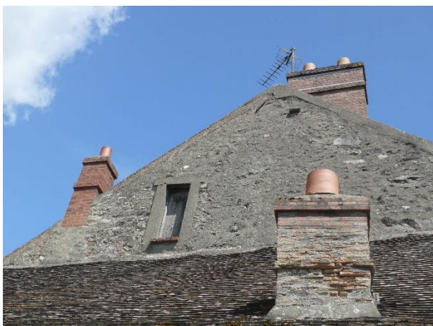
Souche de cheminée route de Villeneuve
