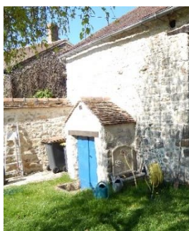
Cave avec escalier sous auvent maçonné extérieur à la maison
