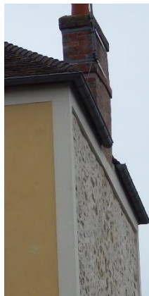
Élévation avec enduit couvrant et pignon enduit à pierre vue
