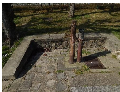
Pompe à eau située place de la gare
