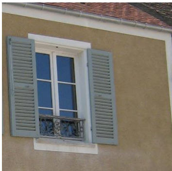
Maison de bourg avec un enduit couvrant plâtre chaux
