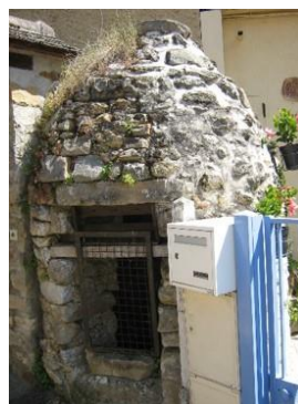
Puits situé rue des boulons
