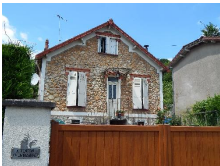
Toiture en saille de rive
