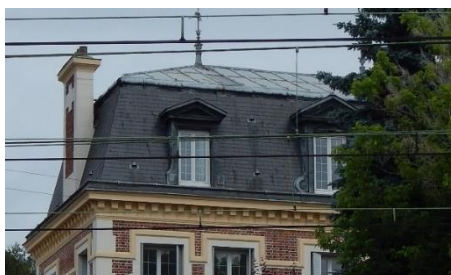
Toiture en ardoise à la Mansart
