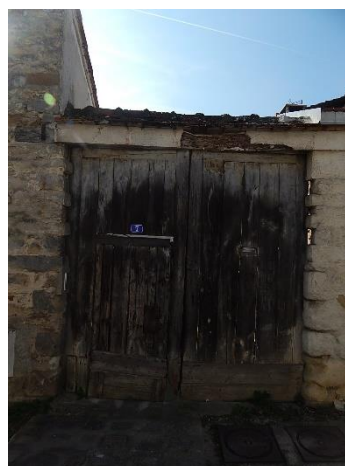
Porte charretière avec porte piétonne
