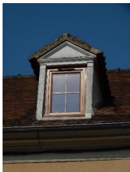
Lucarne à bâtière
