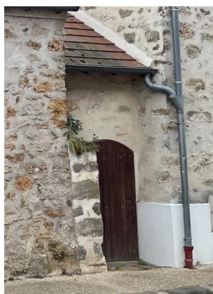
Figure 71 Cave du corps de garde, C.B, PNRGF©
