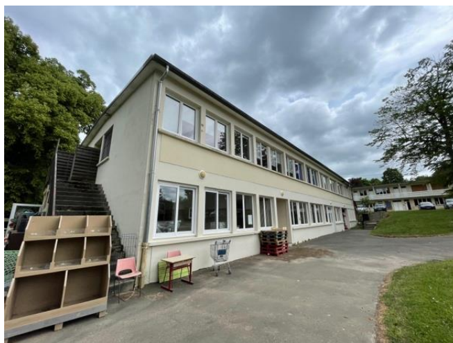
Figure 66 Préfabriqués des années 1960/1970, C.B, PNRGF©
