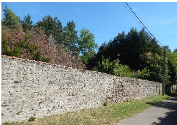
Figure 77 : linéaire de mur au chemin de la brèche, LN
