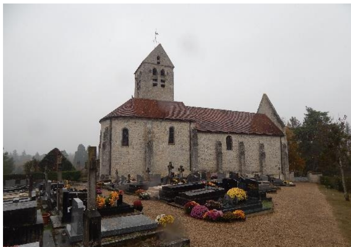
Figure 15 : Vue du mur nord côté cimetière, LN
