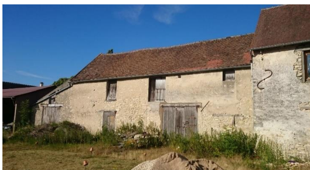
Figure 96 : Toiture en tuiles plates, LN
