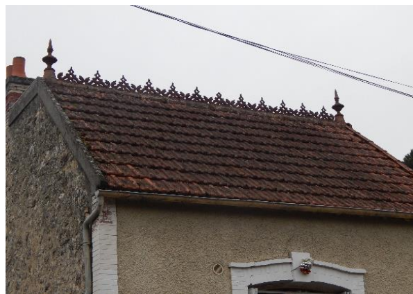
Figure 97 : Toiture d'un pavillon à Villetard, LN
