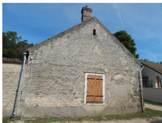
Figure 92 : exemple d'une bâtisse en grès et enduit plein, LN
