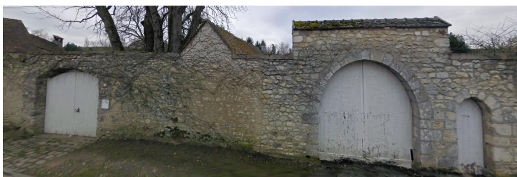
Figure 78 : linéaire de mur du château rue de la grange aux dîmes, LN
