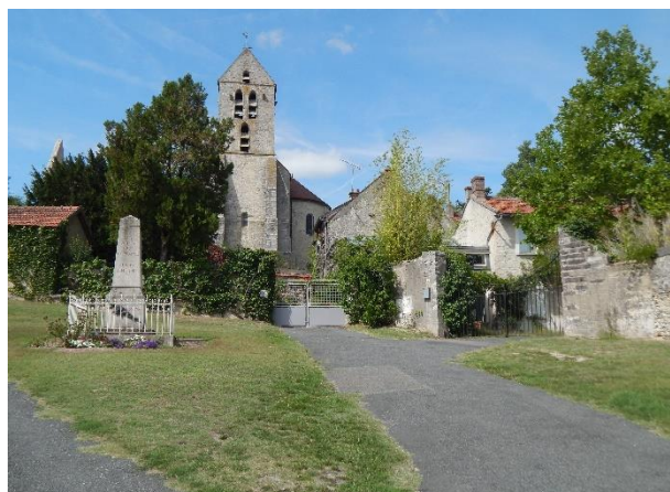
Figure 80 : cour commune place de l'église dans le bourg, LN
