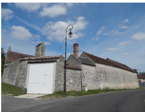
Figure 81 : Ferme en front de rue et sa porte charretière 16 rue de la grange aux dîmes, LN
