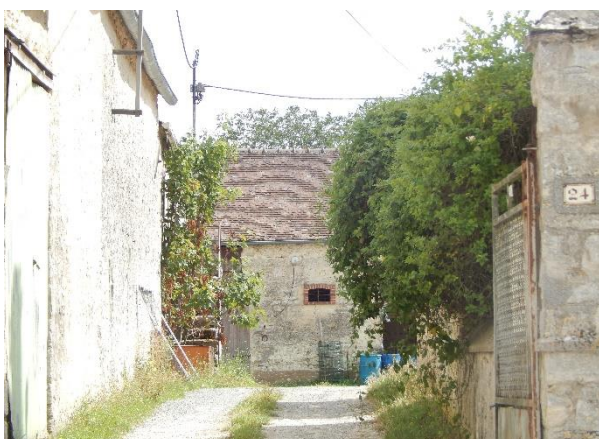
Figure 79 : Cour commune au 24 rue de Boisminard, LN
