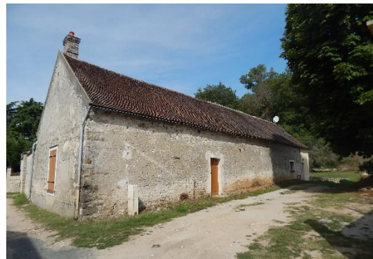
Figure 93 : enduit plein, LN
