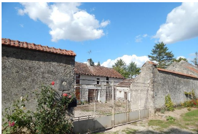
Figure 65 : Exemple de ferme de bourg au 9 rue de Boisminard, LN
