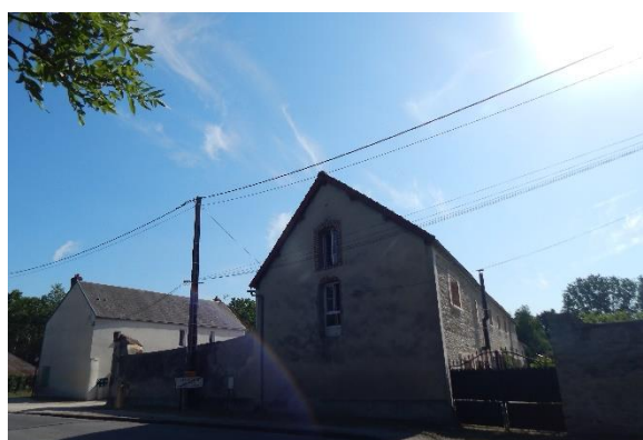
Figure 35 : Relais de poste potentiel à Villetard, LN
