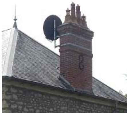
Figure 99 : Souches de cheminé en brique dans le bourg, LN
