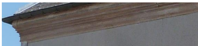
Figure 90 : Exemple d'une corniche moulurée
