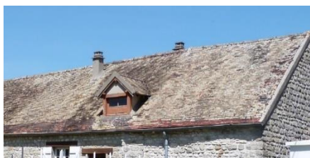
Figure 92 : Exemple d'une toiture en tuiles plates
