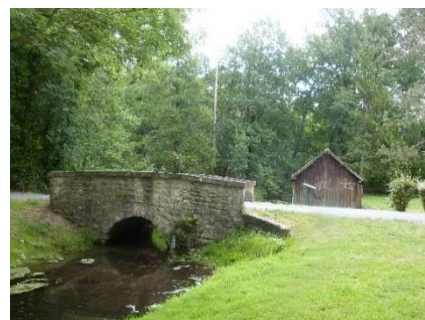
Figure 44 : Vue actuelle du pont du Closeau
