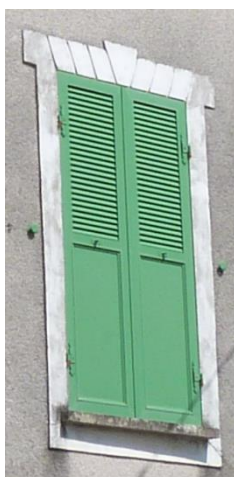
Figure 89 : Exemple d'un encadrement d'une baie travaillé
