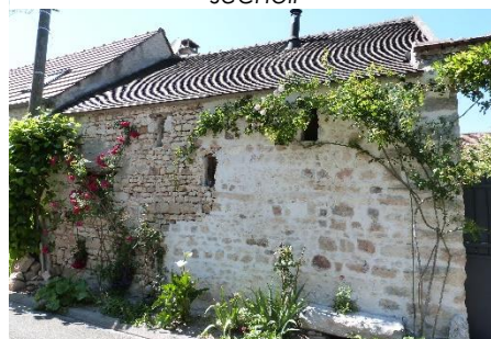
Figure 61 : Exemple d'un ancien séchoir
