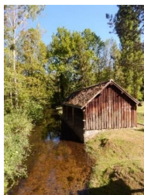
Figure 47 : Vue actuelle du lavoir du closeau
