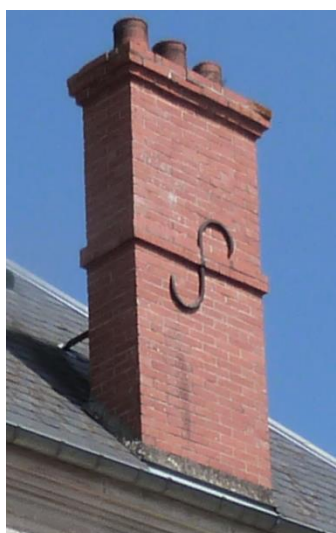
Figure 95 : Exemple d'une souche de cheminée en brique
