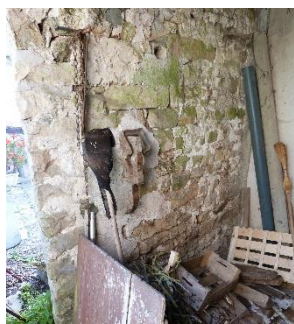
Figure 49 : Puits bouché chez un particulier, rue Lantara
