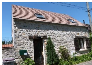
Figure 93 : Exemple d'une toiture en tuiles mécaniques
