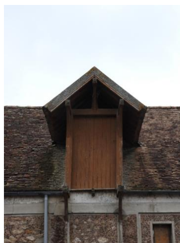
Figure 86 : Lucarne des dépendances de la mairie PNRGF
