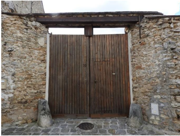
Figure 76 : Porte charretière et chasse-roue PNRGF
