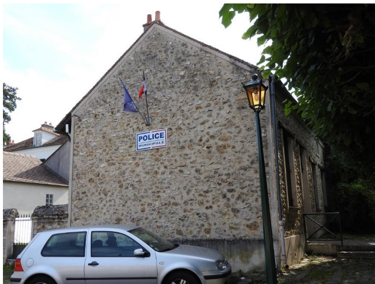
Figure 27 : Le bâtiment abritait l'école de 1855 à 1943 Maintenant la police municipale occupe les lieux PNRGF
