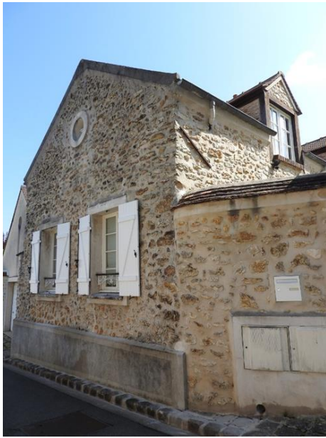
Figure 82 : Toit à deux versants avec le pignon découvert PNRGF
