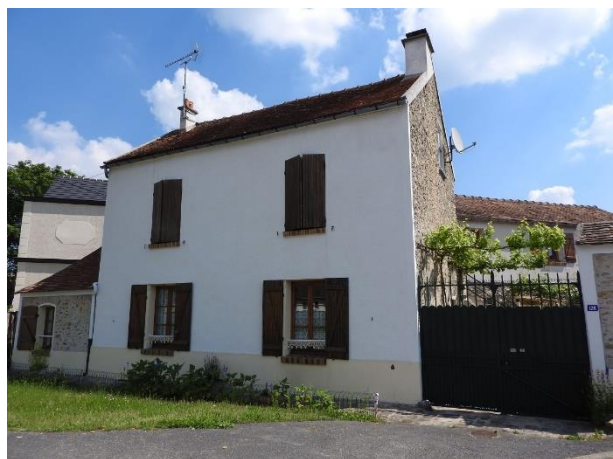
Figure 78 : Façade enduite entièrement PNRGF
