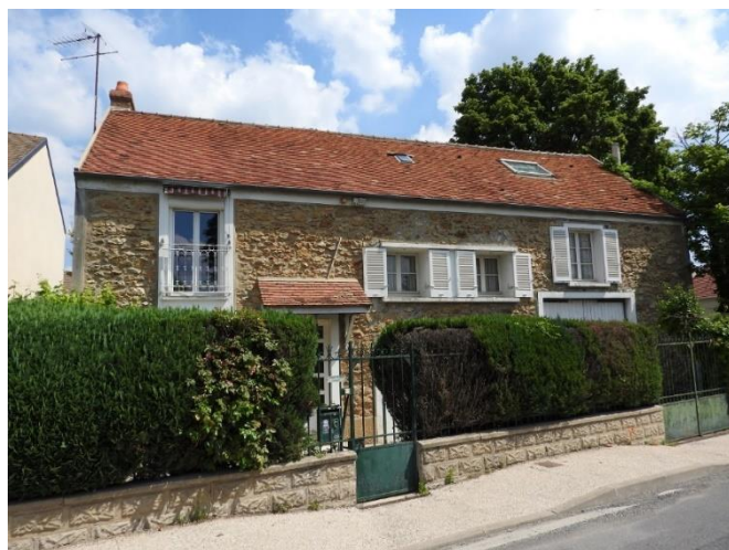
Figure 50 : Ferme de subsistance PNRGF
