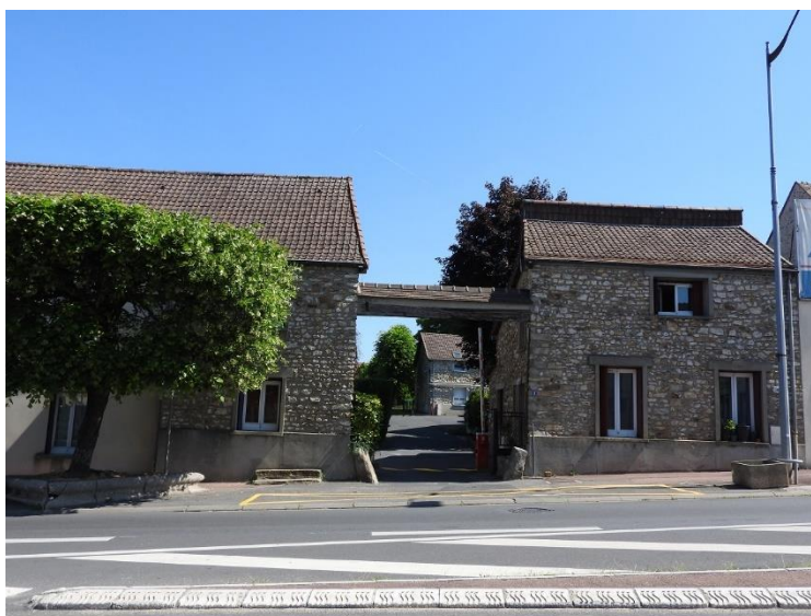
Figure 31 : Ancien relais de poste Avenue de Fontainebleau PNRGF
