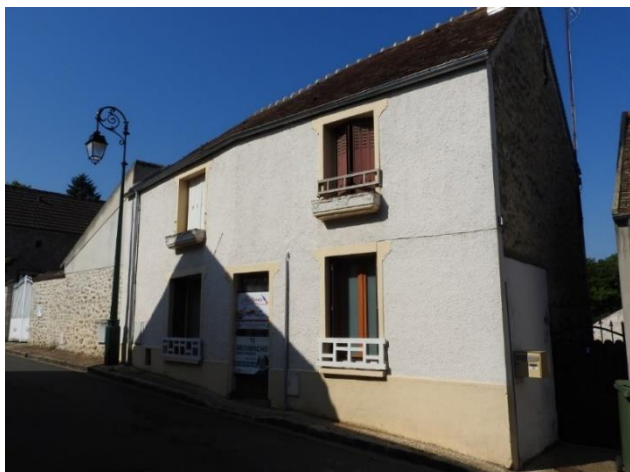
Figure 57 : Maison de bourg PNRGF
