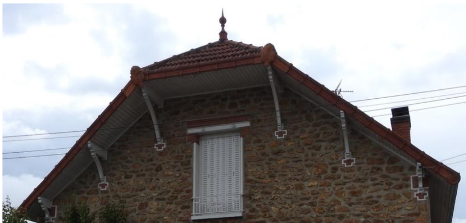
Figure 83 : Toit à quatre versants en croupe avec épis de faîtage et aisseliers PNRGF
