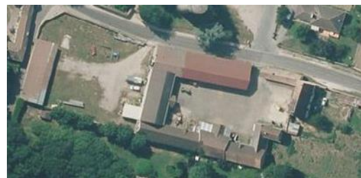
Vue de la ferme du château vert en 2014
