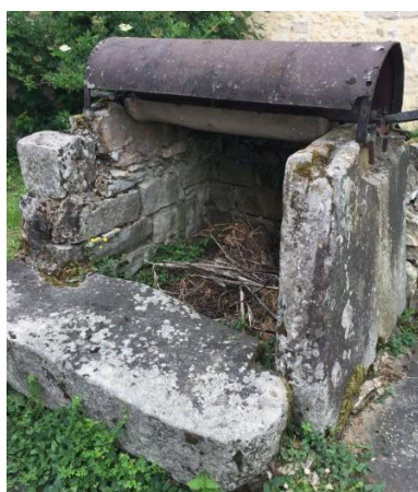
Figure 29 Puits en grès, 2018, © EG
