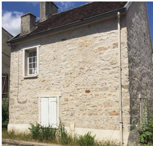
Figure 75 Exemple de mortier couleur sable, 2018, © EG
