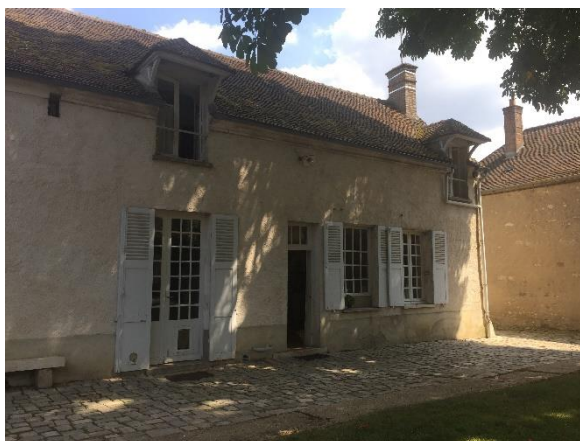
Figure 88 Exemple de gerbière rue Du Buisson, 2018, © EG
