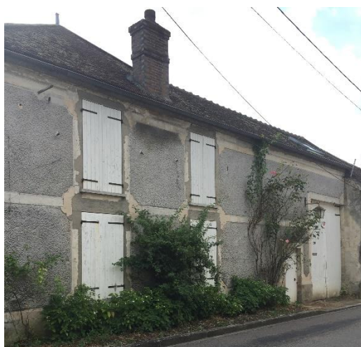
Figure 76 Exemple d'enduit couvrant, 2018, © EG
