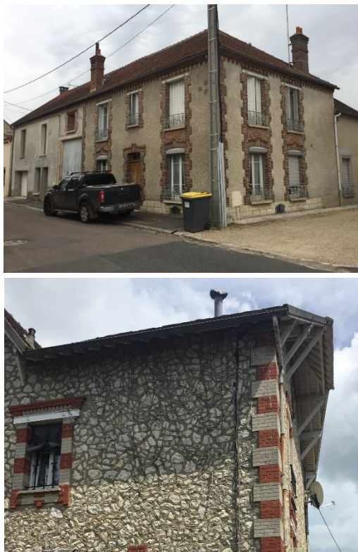
Figure 80 Exemples de toitures rue de l'Eglise, 2018, © EG
