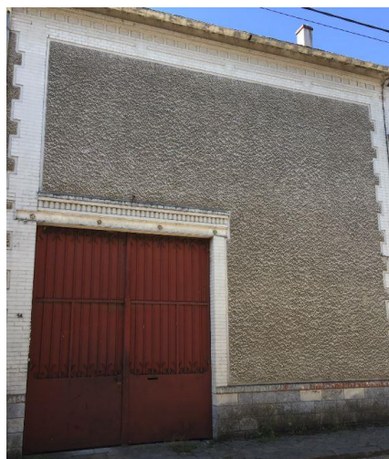
Figure 78 Façade d'une ferme rue René Lefevbre, 2018, © EG
