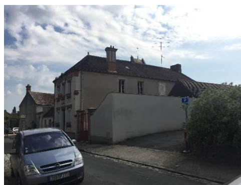
Figure 22 Vue de l'extension de l'école, 2018, © EG
