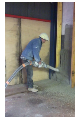
Projection de béton de chanvre
