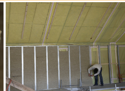
Pose de panneaux de laine de chanvre
