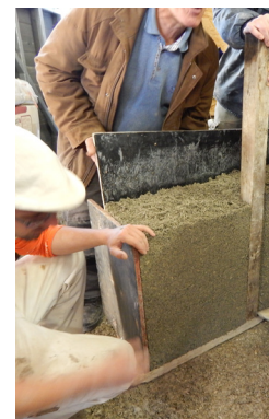
Mur en béton de chanvre banché
