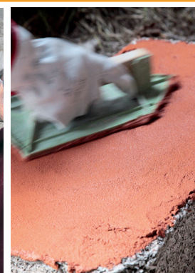
Isolation de toiture en béton de chanvre
