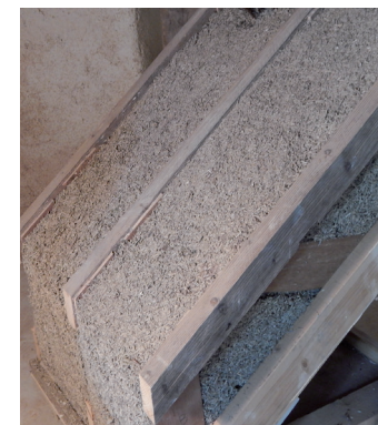
Isolation de toiture en béton de chanvre
